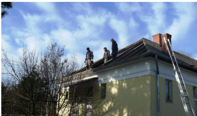
Elkezdődött a tető cseréje
