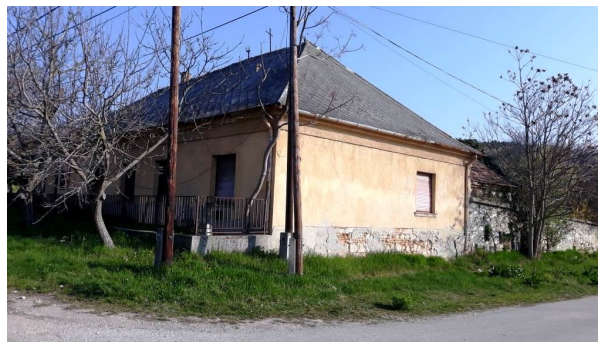
A plébánia jelenleg
